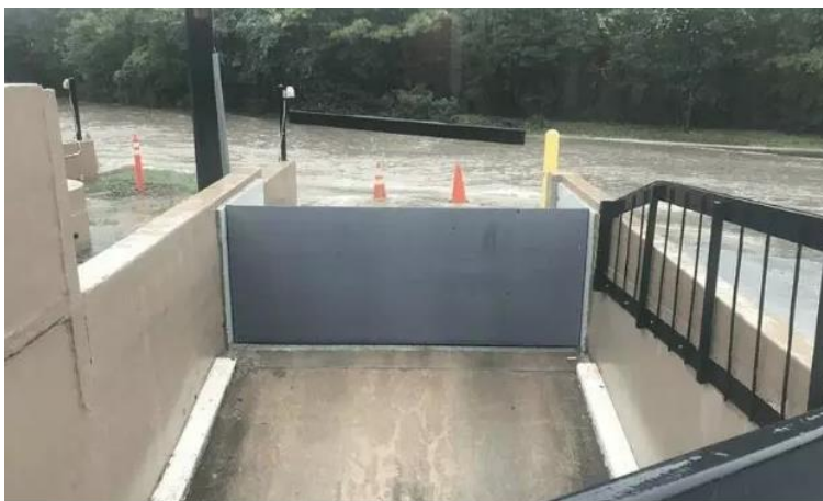
Figur 8383- Eksempel på mekanisk port som kan heises opp ved flom
